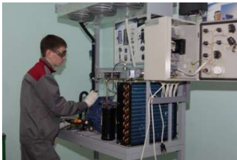
День С2. Модуль М3. Поиск и устранение неисправности в холодильной установке. Снятие параметров воздуха. Запуск холодильной установки
